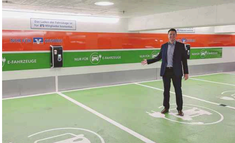
Pressesprecher Patrick Grubba von der Volksbank freut sich über die neuen Ladesäulen in der Tiefgarage der Hauptstelle in Münster.
