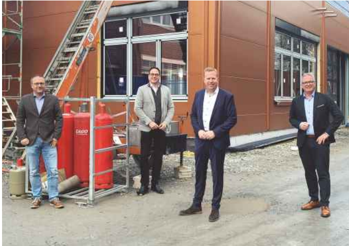
Mit der Modernisierung des BildungsCenters der Kreishandwerkerschaft in Beckum wird die Attraktivität der betrieblichen Ausbildung gefördert und die Versorgung mit Fachkräften im Handwerk gesichert. Davon überzeugten sich die CDU-Politiker Henning Rehbaum (2. v. r.) und Markus Höner (2. v. l.) bei einer Bauführung durch Kreishandwerksmeister Heinz-Bernd Lohmann (l.) und KH-Hauptgeschäftsführer Frank Tischner (r.).
